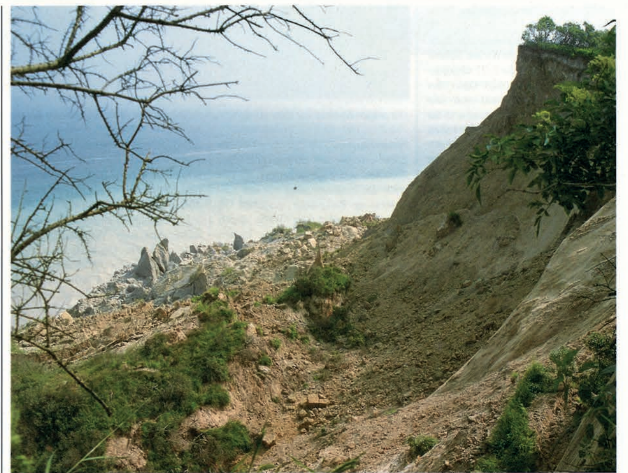
Etwa 120.000 m 3 Erdmassen rutschten östlich des Swantiberges in die Ostsee.
