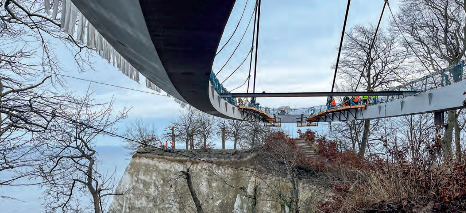
Der neue 185 m lange Skywalk, hier noch in der Bauphase, schwebt über dem Königsstuhl.
